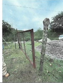
Foto 2: CAMBIO DE CERCO PERIMETRAL
